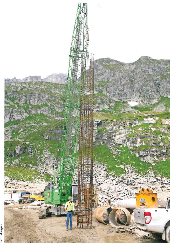
2.200 METER SEEHÖHE Ein Sennebogen-Seilbagger unterstützte als Kran, Bagger und Greifer die Drehbohrgeräte und war eine Art Joker, wenn ein Rohr feststeckte.
